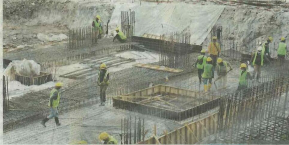
Cuaca panas ekstrem membahayakan keselamatan dan kesihatan pekerja yang melakukan kerja di tapak pembinaan. - Gambar hiasan
